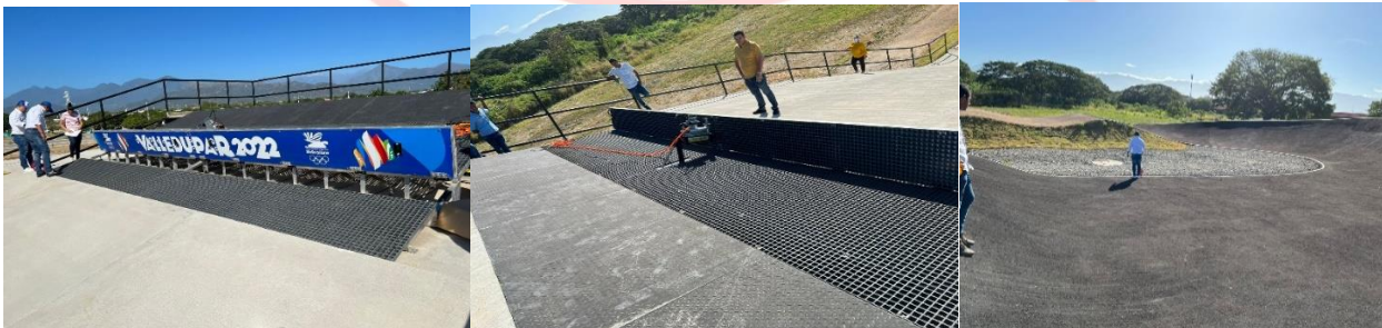
Sistema de partidador straight s3 pro gate – Sistema de controles – Pista Biciclos
